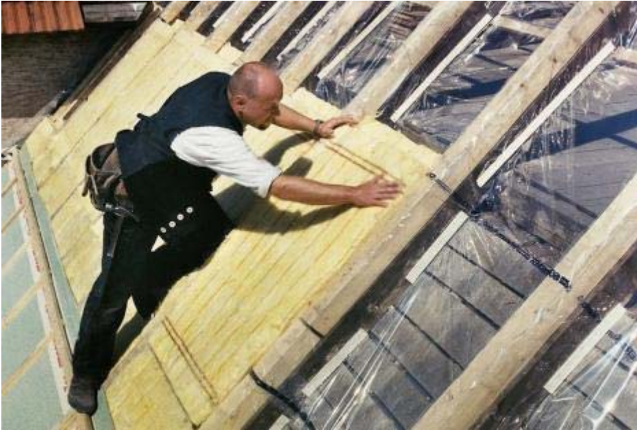
Ein Dachdecker befestigt auf einem abgedeckten Hausdach isolierende Glaswolle Foto: dpa
