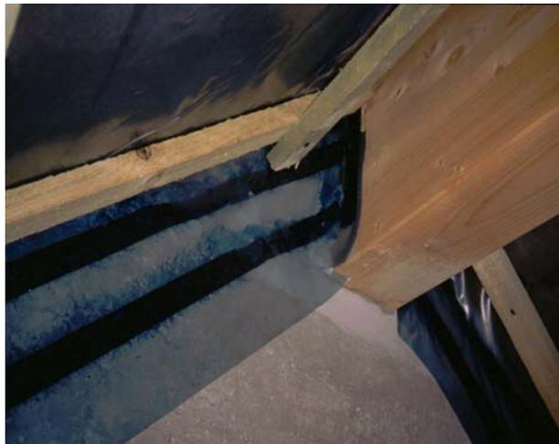
Hier wurde die Dampfbremsefolie zweifach mit doppelseitigem Butylkautschukklebeband an der Giebelwand befestigt. Anschließend werden die Verklebungen mit Andruckleisten fixiert.
