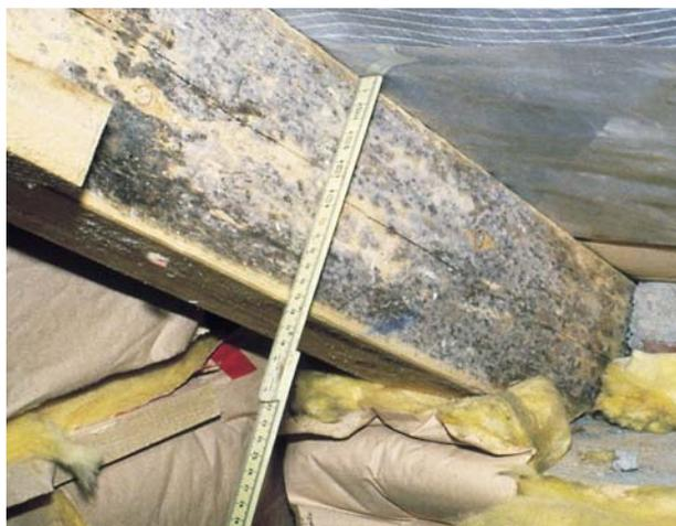
Dieser Sparren ist von ausströmender warmer und feuchter Raumluft so stark durchnässt worden, dass er begonnen hat zu faulen.
