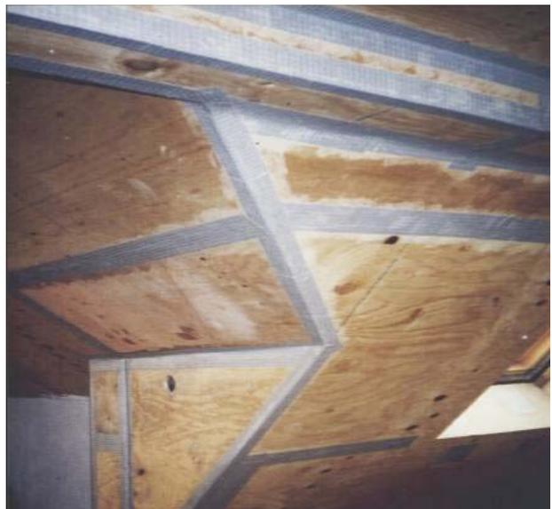
Auch ohne die Verwendung von Folien ist die Herstellung einer luftdichten Ebene möglich. Bei diesem Gebäude wurde sie mit Sperrholztafeln realisiert. Die Abdichtung der Fugen erfolgte mit gewebeverstärktem Klebeband.
