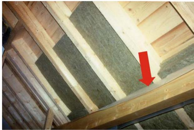
Gut geplante Arbeit ist leicht und effektiv! Wird vor dem Auflegen der Sparren auf die Pfetten ein stabiler Folienstreifen gelegt, ist der dichte Anschluss der Dampfbremse kein Problem mehr.
