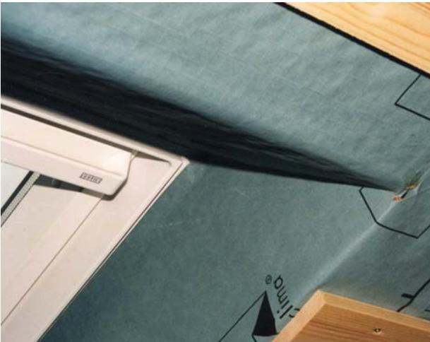
Bei herkömmlichen Dachflächenfenstern (ohne Formteil für die Laibung oder vormontierte Folienstreifen) muss die Dampfsperrefolie in die Nut des Blendrahmens eingeklebt werden.
