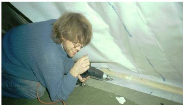
Hier wird beim Dachausbau im Altbau die Dampfbremse mit doppelseitigem Klebeband und einer Anpressleiste am Betonboden verschraubt.
